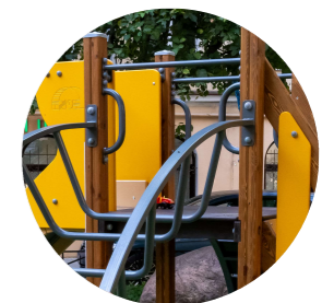
Игровые элементы выполнены из металла, окрашены порошковой краской в цвета RAL
