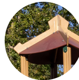
Крыша из березовой фанеры марки ФСФ для защиты деревянных элементов от осадков
